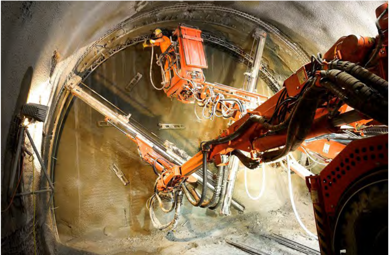
Im Fröschnitzgraben u. an d. Baustelle Grautschenhof kommt bei den Arbeiten die Neue Österreichische Tunnelbaumethode zur Anwendung
