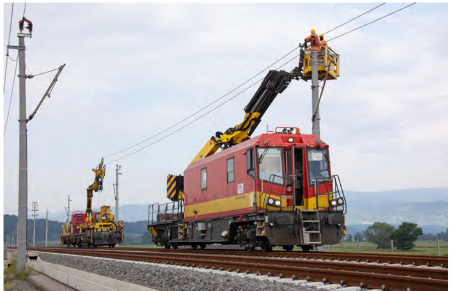
Bei den Arbeiten an der Oberleitung kamen hochmoderne Spezialfahrzeuge zum Einsatz
