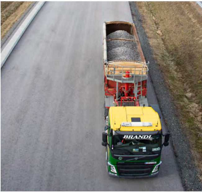
Schotteraufbringung mit LKW am zukünftigen Bf. Weststeiermark
