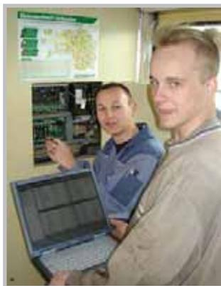
Foto links: Überprüfung und Optimierung der digitalen Motor- und Generatorsteuerung sowie Regelung (Leistungssteuerung) mittels Servivesoftware durch Martin Jauk (li) u. Matthias Dangl (re).
