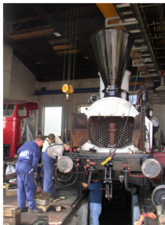
Die Reparaturarbeiten laufen auf Hochtouren; ein Blick auf den erneuerten Kessel
