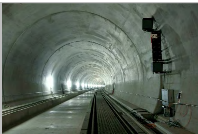
Foto links: Hengsberg Tunnel, Fahrtrichtung Wettmannstätten. Rechts ist das Zwischensignal E202 des Bahnhofes Hengsberg zu sehen. Das eigentliche Einfahrsignal befindet sich noch außerhalb des Tunnels zwischen der Unterführung Weitendorf und dem Hengsberg Tunnel.
