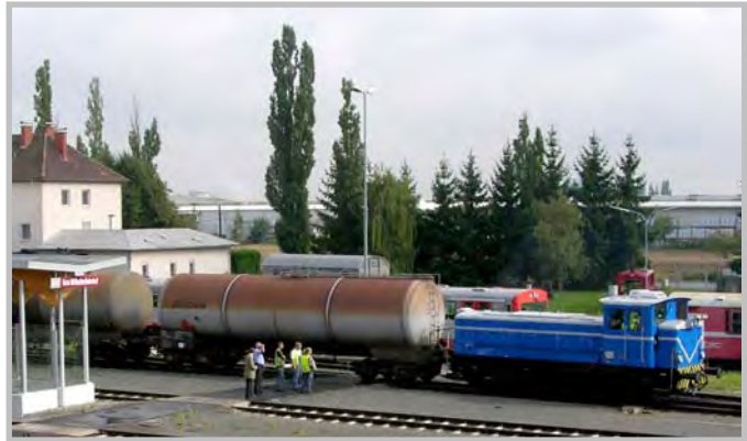
Foto unten: Erste Belastungsfahrt mit 1200 Tonnen im Vershub am Graz Köflacherbahnhof Ende August 2007
