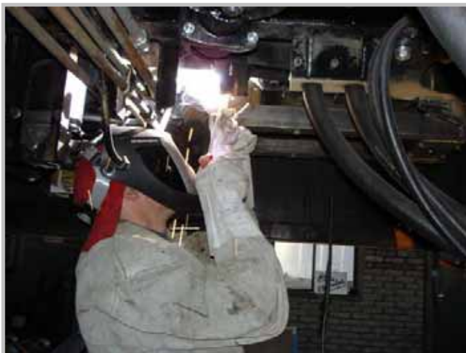
Foto oben: Andreas Hammer in Überkopfschweißposition für die Befestigung des Kompressortragrahmens am Triebwagen VT70
