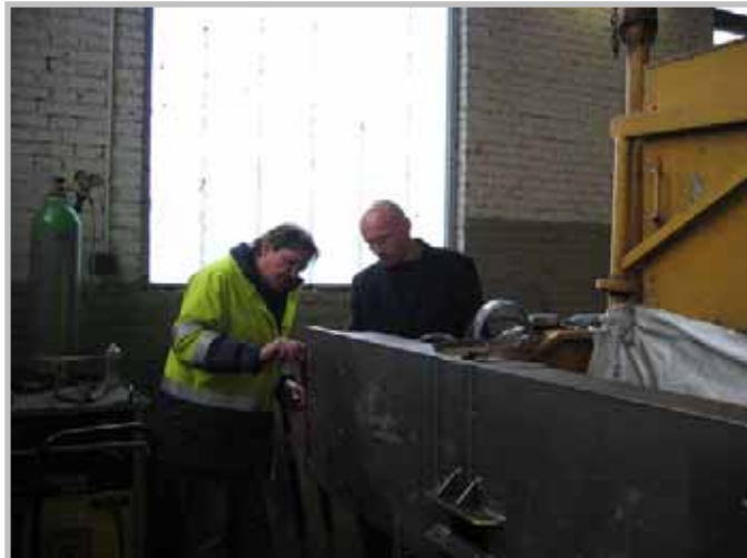
Foto oben: Schweißaufsicht Dipl.-HTL-Ing. Friedrich Felber (re) und Manfred Zöhrer bei der Sichtkontrolle und Abnahme der Wurzelschweißnaht der neuen Pufferbrust der Gleisbaumaschine
