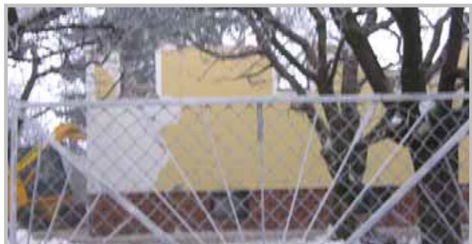
Foto oben: Nach Abtragung der durch den Brand zerstörten Gebäudeteile stehen nur mehr die Grundmauern des Hauses Beil (HM; 1.2.2006)
